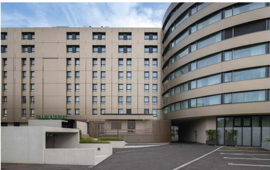
le noyau central, ainsi que sur les pignons des façades. La surélévation des deux niveaux est une structure porteuse légère composée bois-métal, permettant ainsi un gain de poids et de rapidité de mise en place. Toutes les cellules sanitaires ont été conservées et rafraîchies. L'intérieur est revêtu de différents types de marbre, le tout complété par une importante gamme d'accessoires.
